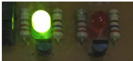
Gambar 17 Kondisi LED Menambahkan Air Tawar
