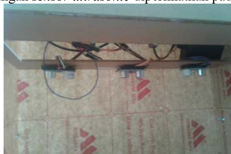
Gambar 4 Pemasangan sensor ultrasonic
