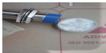
Gambar 5(b) Pemasangan sensor ultrasonic
